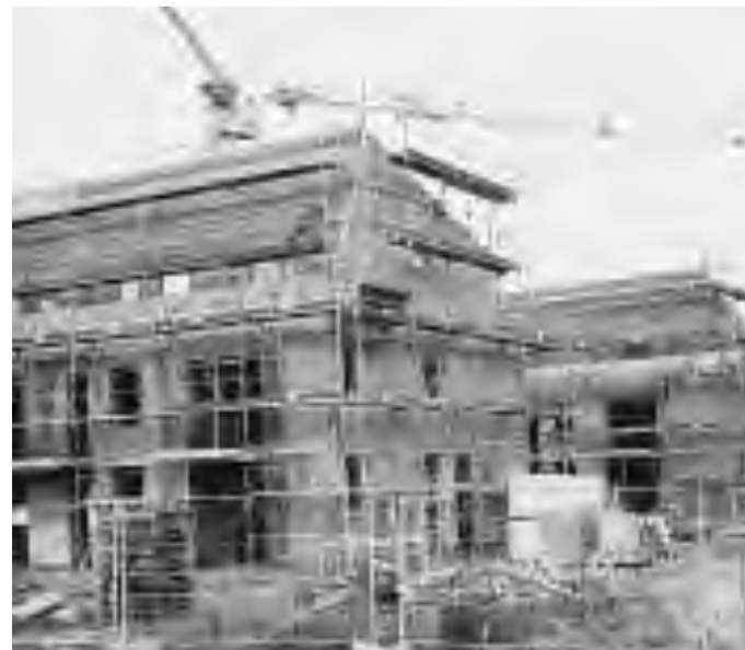
Un cantiere edile
