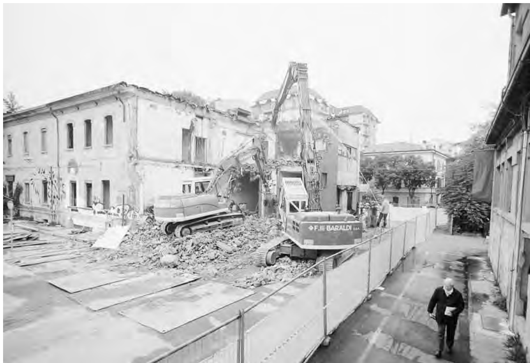
Un'immagine delle recenti demolizioni nell'area ex Amcm
