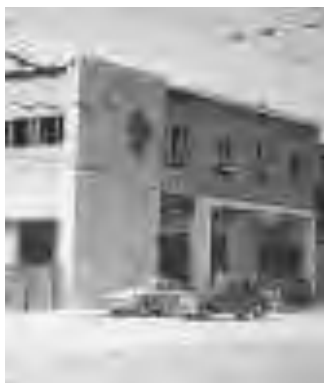
La palazzina come era negli anni '50 e a fianco le operazioni di demolizione avviate ieri mattina
