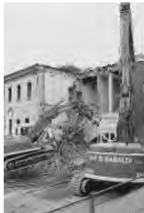
Un momento delle operazioni di demolizione
