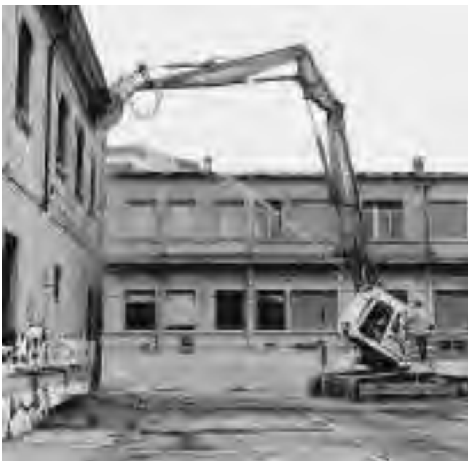
La ruspa arriva sulla palazzina Vecchi
