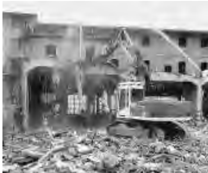
Le operazioni di demolizione all'ex-Amcm
