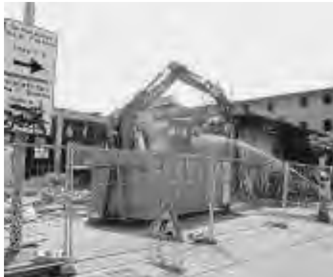
Un altro momento delle operazioni di demolizione avviate ieri mattina
