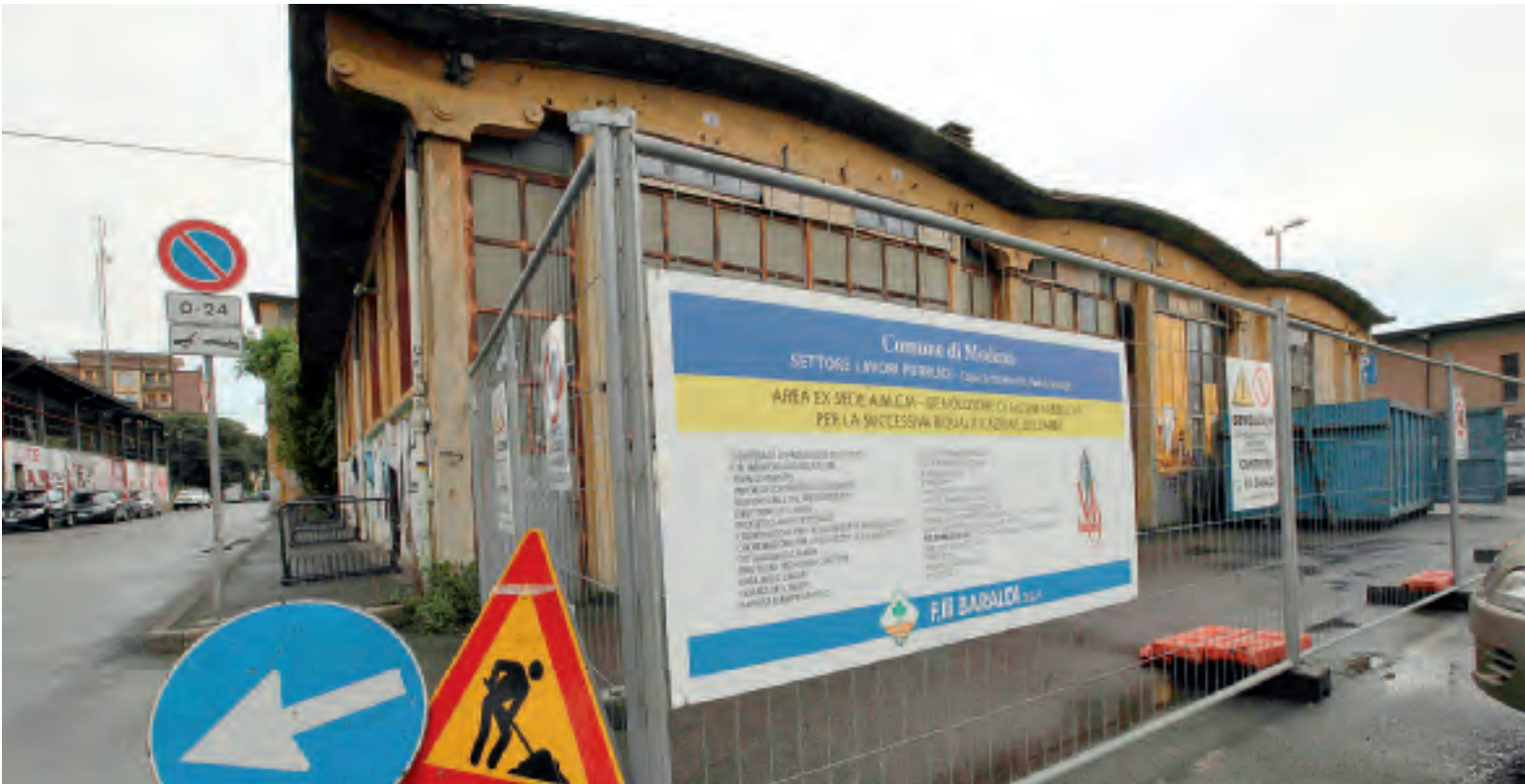
CANTIERE Alla ex Amcm sono comparse le transenne che annunciano la demolizione, ma sulla data di inizio lavori la polemica è rovente
