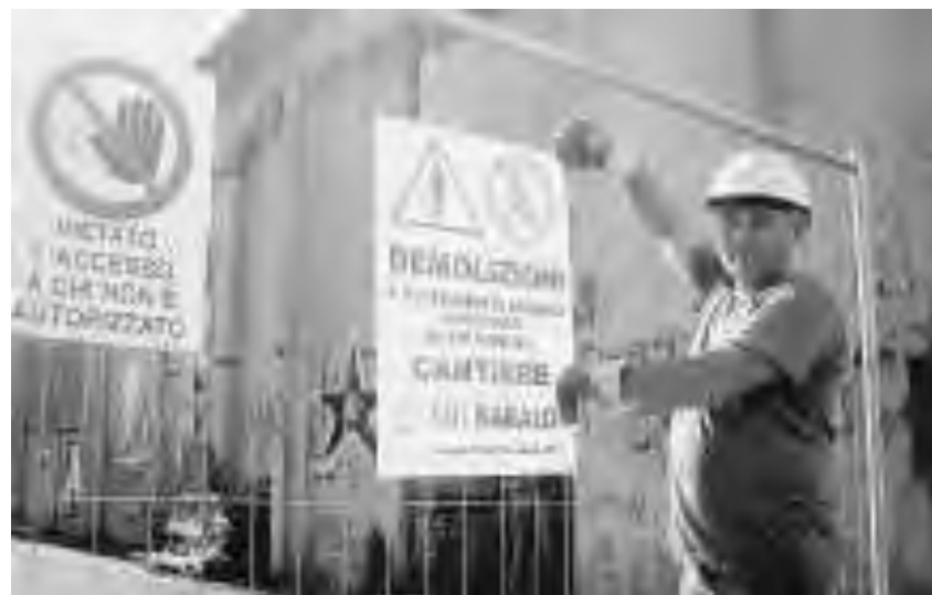
Un operaio installa i catelli di cantiere all'ex Amcm. A sinistra due edifici nell'area di via Sigonio
