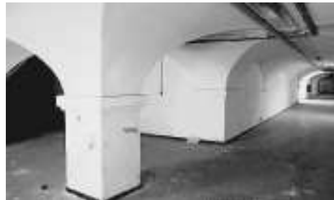
Gli ambienti interni dove sono iniziati i lavori di restauro
