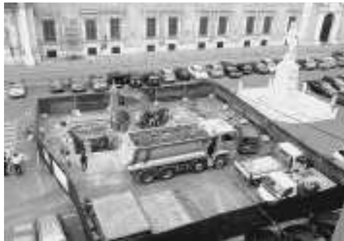
Scavi in piazza Roma: polemiche sul parcheggio interrato
